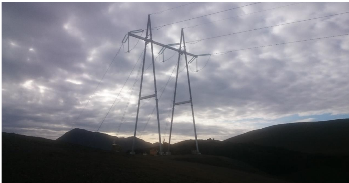
Mynd 3. Frístandandi hormmastur eins og notað verður á nokkrum stöðum í stað stagaðra súluhorna. Myndin er af fastmastri í Kröflulínu 4.
