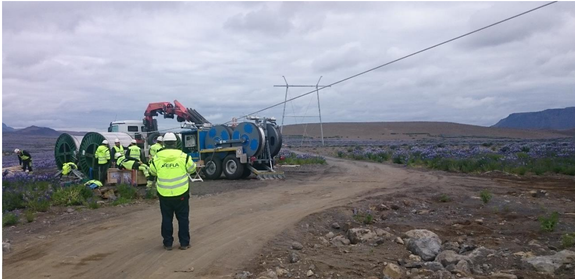
Mynd 7. Strenging leiðara. Myndin er frá byggingu Bakkalína.
