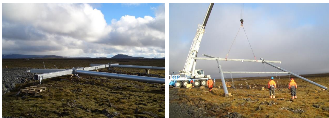
Mynd 6. Myndir sýna vinnu við samsetningu og reisingu stagaðs burðarmasturs af M-gerð. Myndirnar eru frá byggingu Reykjaneslínu 1.
