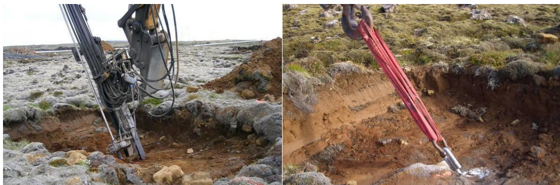
Mynd 5 Til vinstri sér hvar borað er fyrir bergbolta og myndin til hægri sýnir bergboltaprófun.
