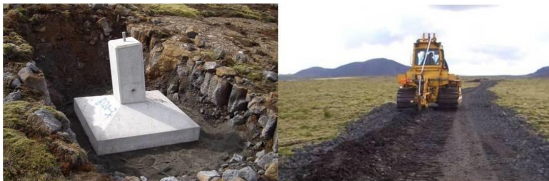
Mynd 4. Til vinstri má sjá forsteypta undirstöðu M-masturs og hægri sést hvernig jarðskaut er plægt í vegslóð.
