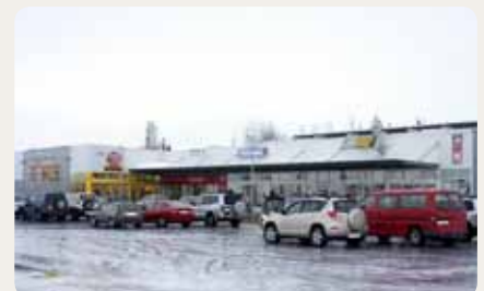
Pawilon sklepowy, Egilsstaðir
