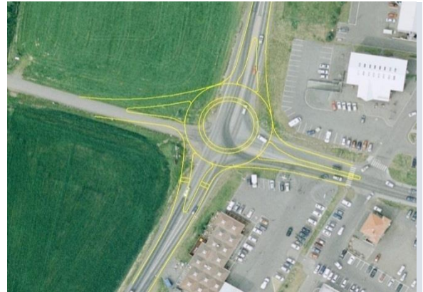
Mynd 3.22 Gatnamót Fagradalsbrautar og Hringvegar. Frumdrög að hringtorgi. Mynd: Erna Bára Hreinsdóttir, Vegagerðin.
