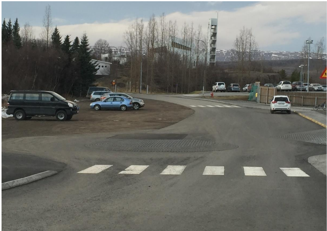
Mynd 3.11 Yfirkeyranlegt hringtorg við Egilsstaðaskóla.
