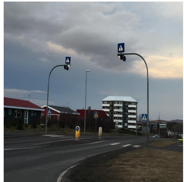
Mynd 3.10 Gangbraut yfir Seyðisfjarðarveg hefur verið endurnýjuð en þar er miðeyja og góð lýsing.
