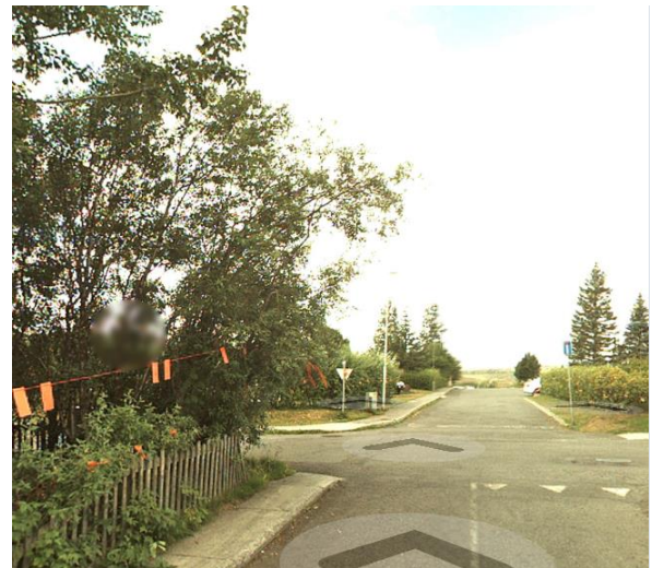
Mynd 3.5 Gatnamót Miðfells og Lagarfells, hér er ekki göngubverun. Lagt er til að snyrta mikinn trjágróður á horninu sem skerðir sjónlínur. Mynd:ja.is
