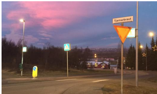
Mynd 3.16 Gangbraut yfir Fagradalsbraut við gatnamót Tjarnarbrautar hefur verið mikið endurnýjuð, með miðeyju og ljósaskilti, og skal skoða betur reynslu þeirra aðgerða.
