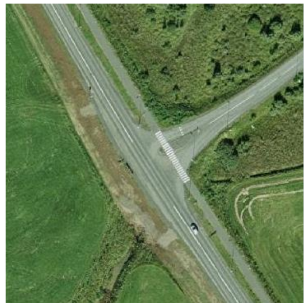
Mynd 3.15 Gatnamót Flugvallarvegs og Hringvegar eru óþarflega breið. Lagt er til að þrengja gatnamótin, færa biðskyldumerkingu á Flugvallarvegi nær gangbrautinni og bæta við einu gangbrautarskilti. Mynd: map.is
